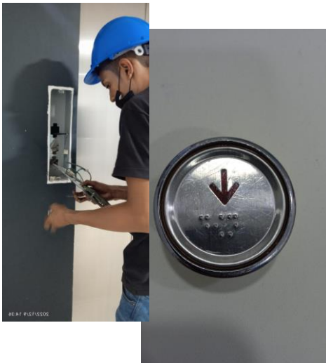
Reposición de pulsador de bajada piso 12 ascensor 3.
