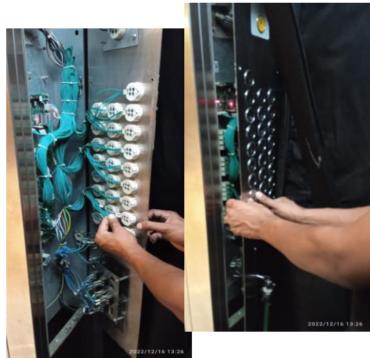
Reposición de pulsador E3 ascensor de carga.
